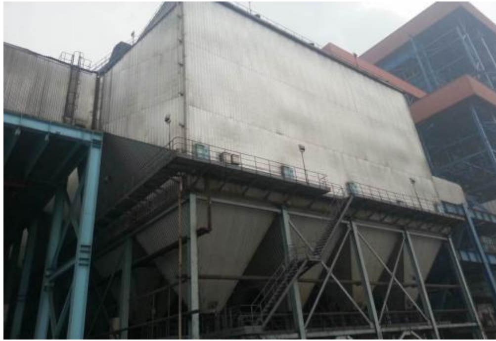
图 5-4 电除尘器本体布置场地
