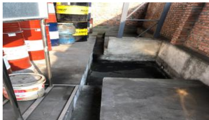
B. 库房周边隔油池及管道
