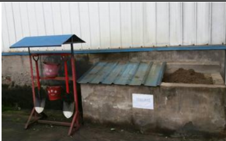
C. 库房消防设施
